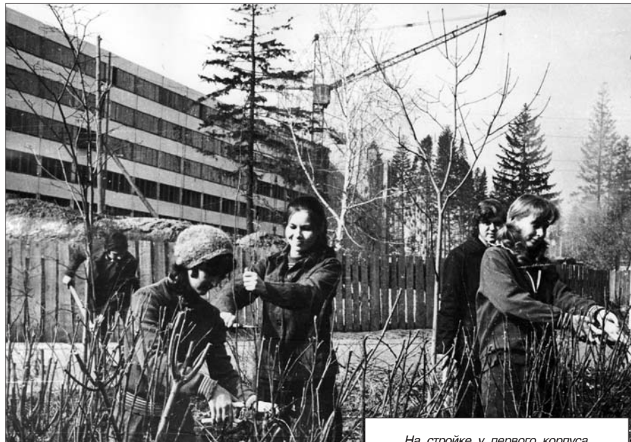
На стройке у первого корпуса
