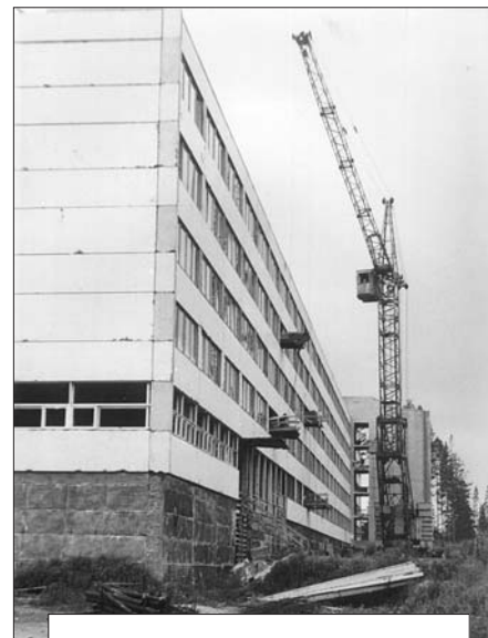
Строительство корпуса № 1 ИМИ
